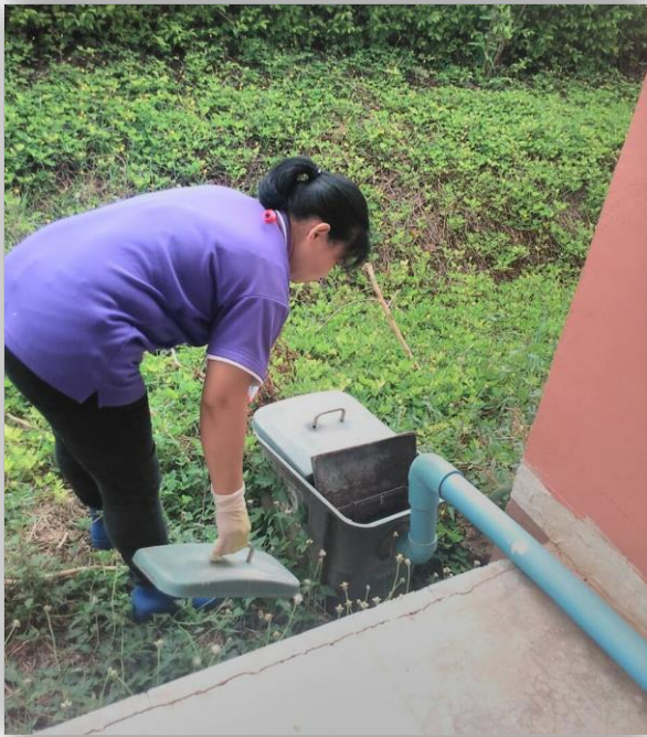
ภาพ 2 การทำความสะอาดบ่อดักไขมัน
