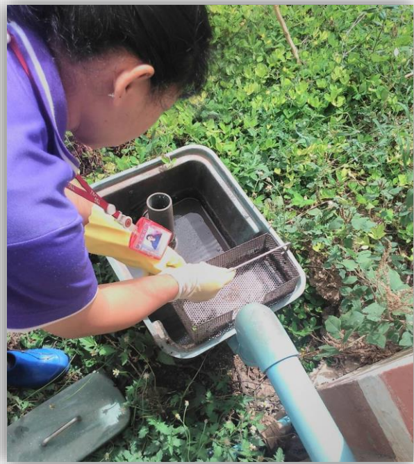
ภาพ 2 การทำความสะอาดบ่อดักไขมัน
